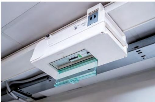
La distribuzione di energia decentrata dei dispositivi di ricarica dei veicoli elettrici con il sistema di blindosbarre è la soluzione ottimizzata per parcheggi multipiano coperti e garage. I kit di distribuzione EVlink con cassette di derivazione preassemblate, permettono il collegamento diretto alla sbarra colletttrice e di risparmiare tempo e costi durante l'installazione. Gli ampliamenti possono essere realizzati rapidamente e in sicurezza.
