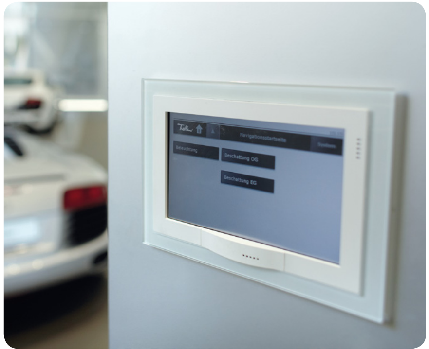
Schön, einfach, übersichtlich und doch umfassend: Sämtliche Verkaufsräume werden mittels KNX-Touch-Panel 7" gesteuert.
