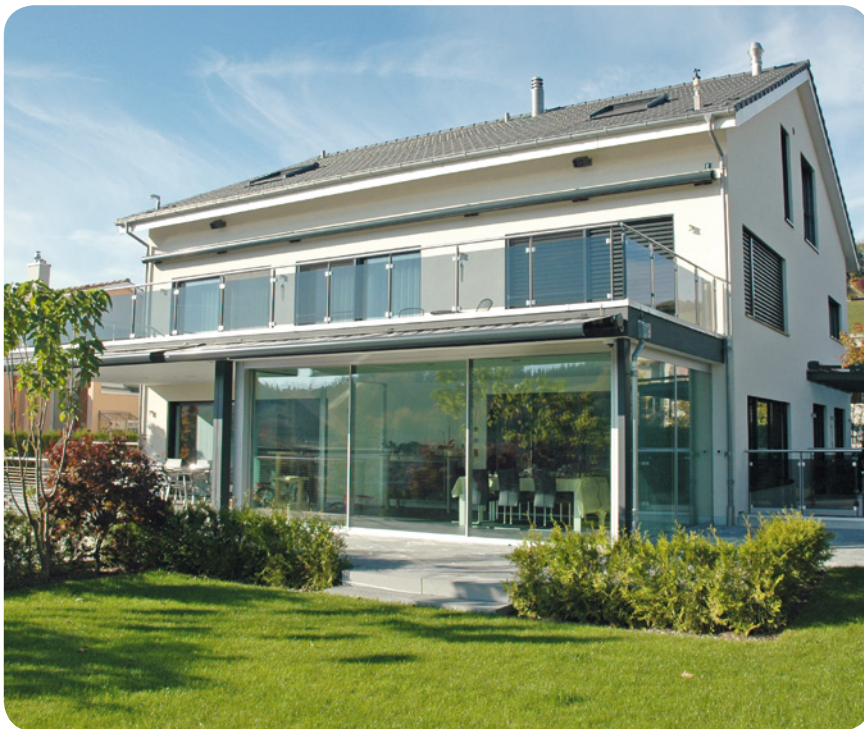
Selbst die grossen Storen- und Jalousiefächen werden per Wetterstation über KNX verwaltet.
