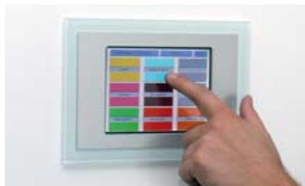
**Zentrale Bedienung der gesamten Haussteuerung über ein Touchpanel im gleichen Feller Edizio due-Design mit Glasrahmen wie alle Taster und Steckdosen im Haus.**
