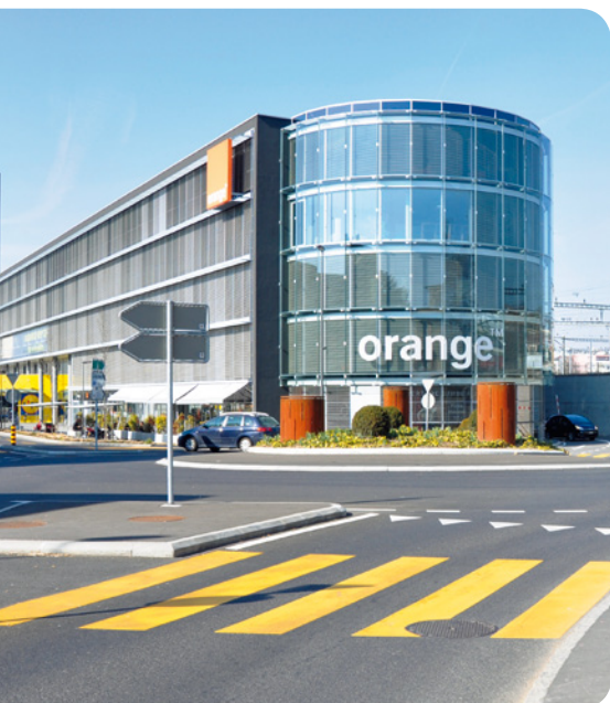
Situation rêvée au centre de Renens, dans le splendide immeuble commercial d'Orange.
