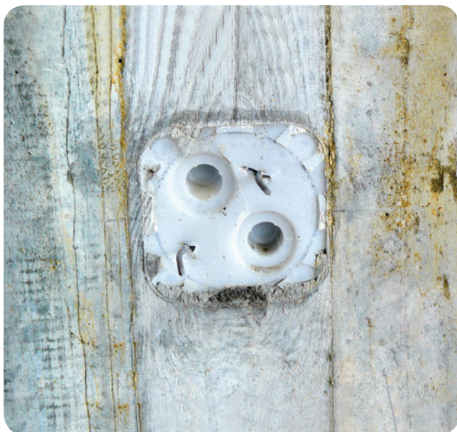
Boîte VIB côté coffrage.
