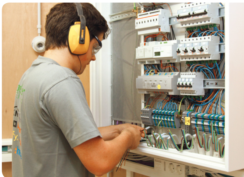
Le câblage d'un tableau dans le stress au championnat d'Europe des installateurs électriciens à Bâle.
