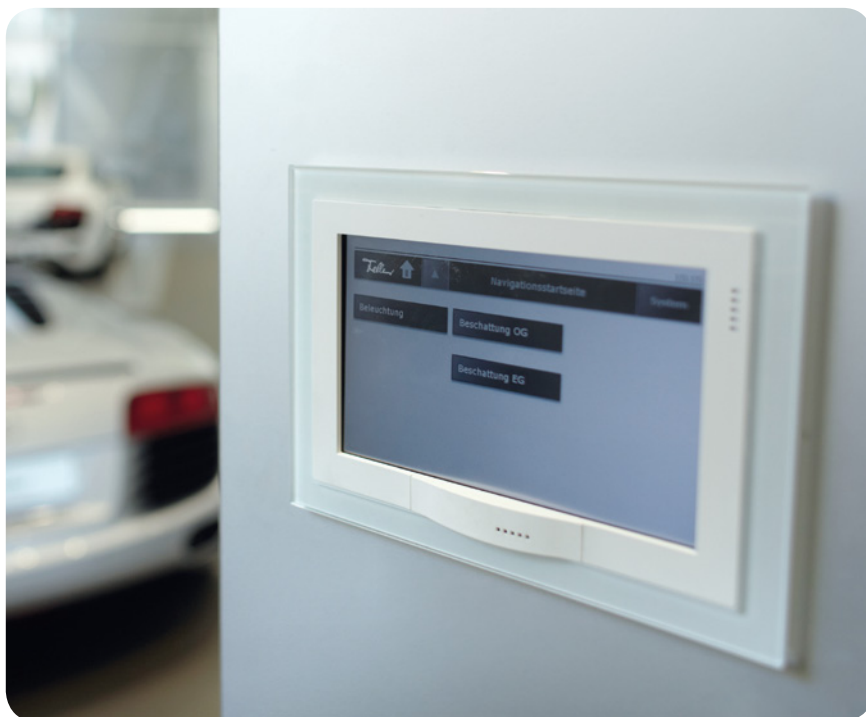
Simple, beau, clair mais complet: tous les locaux de vente sont pilotés via un écran Touch-Panel 7" KNX.
