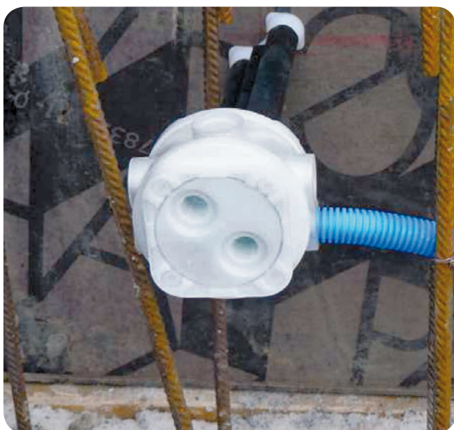
Boîte VIB sur le côté opposé du coffrage.
