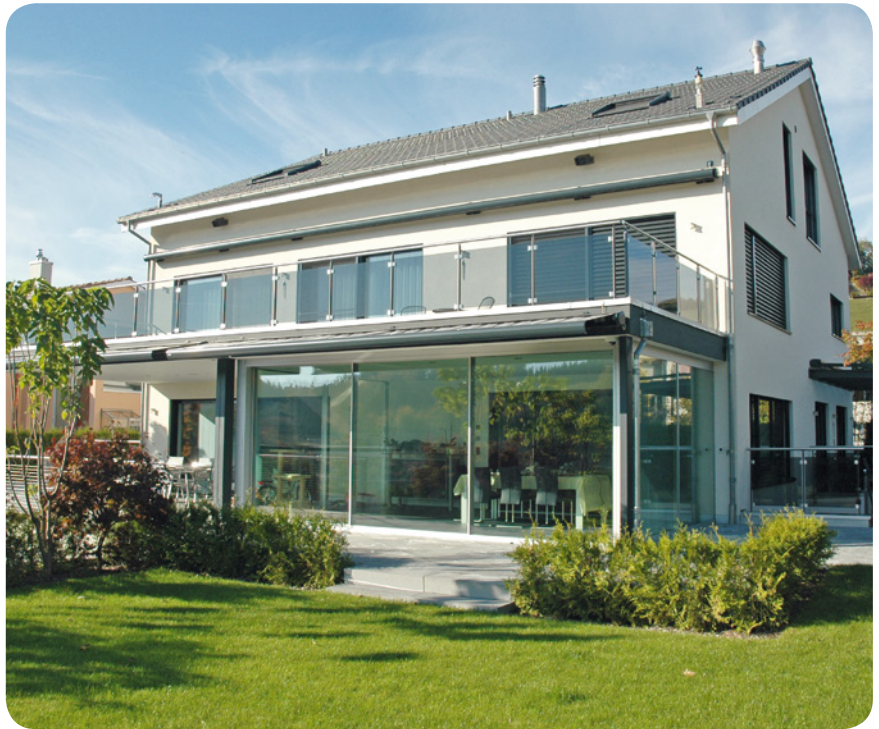
Les grandes longueurs de stores bannes et de stores à lamelles sont gérées par KNX via la station météo.
